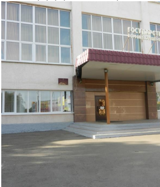
Фото 1,2,3,4,5 – Входы, выходы в здание
