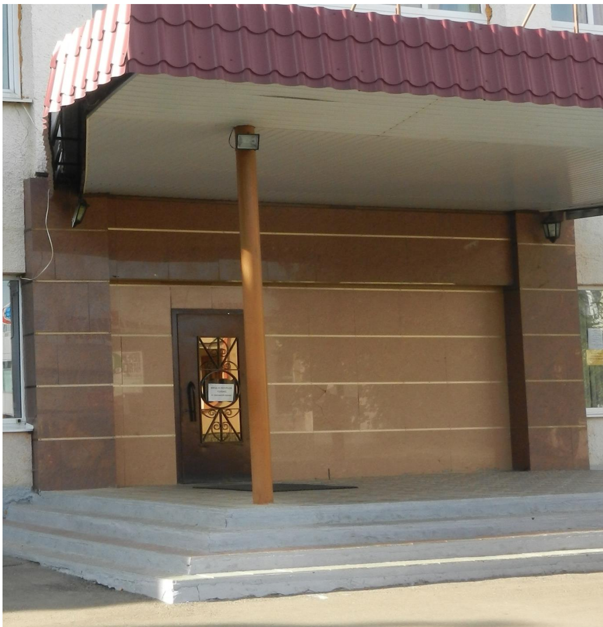
Фото 1 Входная лестница, дверь, площадка
